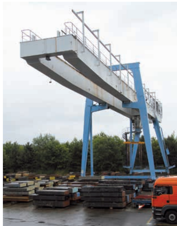
Der Portalkran kann bis zu 20 Tonnen heben.
