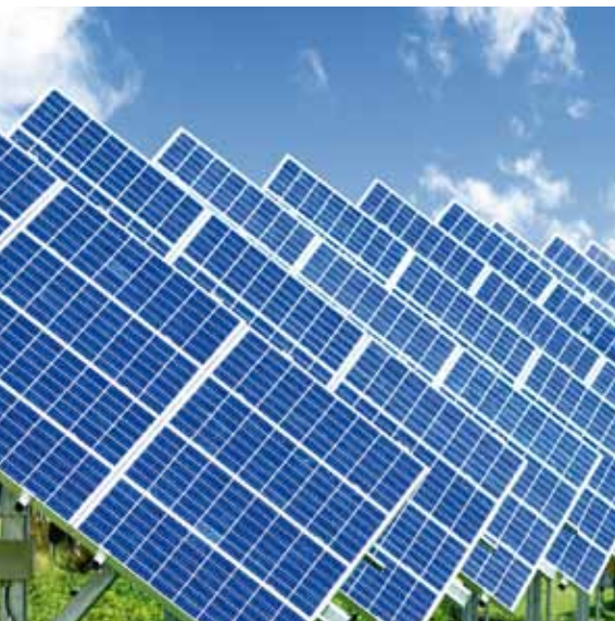
Rahmenkonstruktion für Solarmodule
