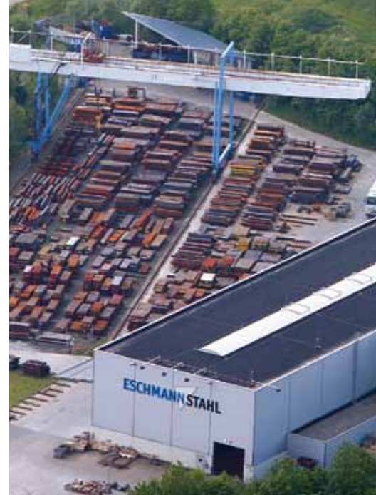
Das große Stahllager in Wehrath
